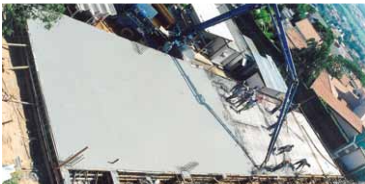
Construção Bloco B, em 2001
